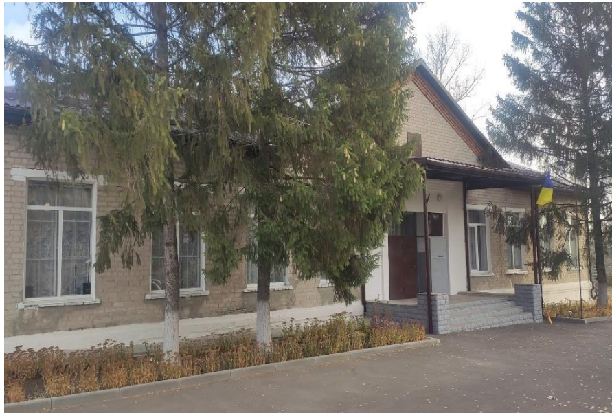
Рисунок 47. Нежитлова будівля за адресою село Шебелинка, вул. Центральна, 19
