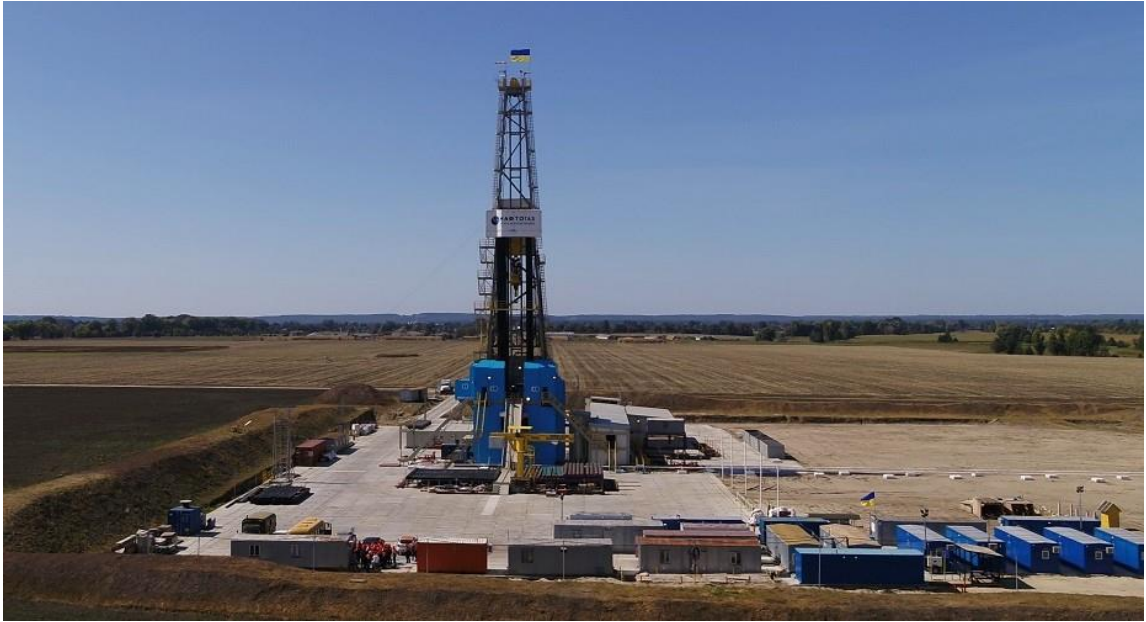
Рисунок 2. Бурова установка Нафтогазу
